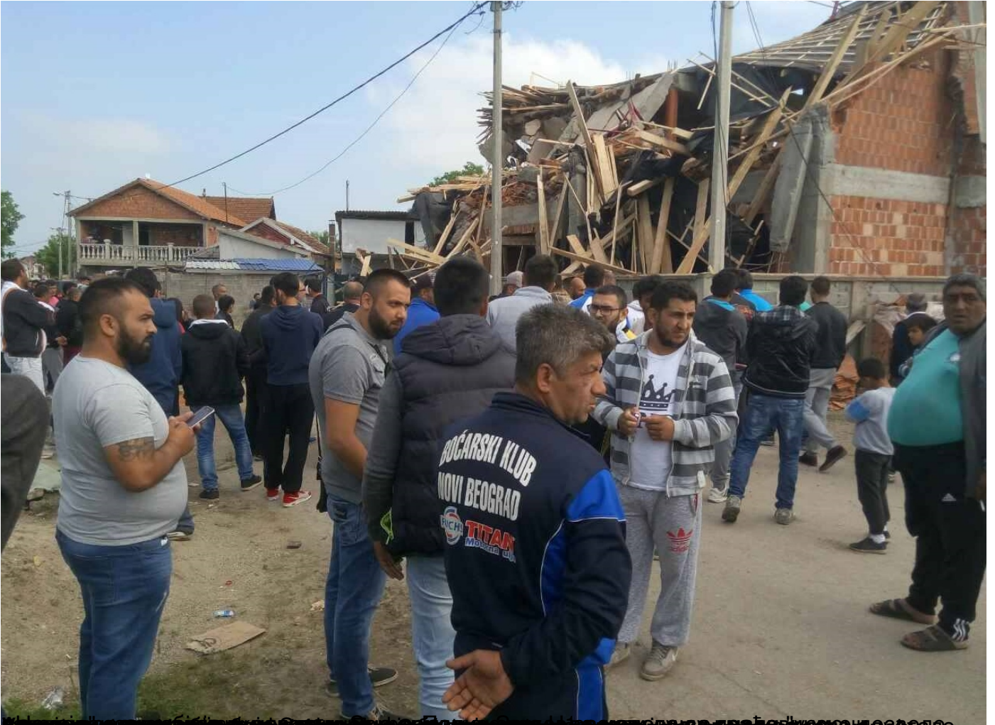
Исламска заједница у Земун пољу одложена акција уклањања нелегалног објекта
