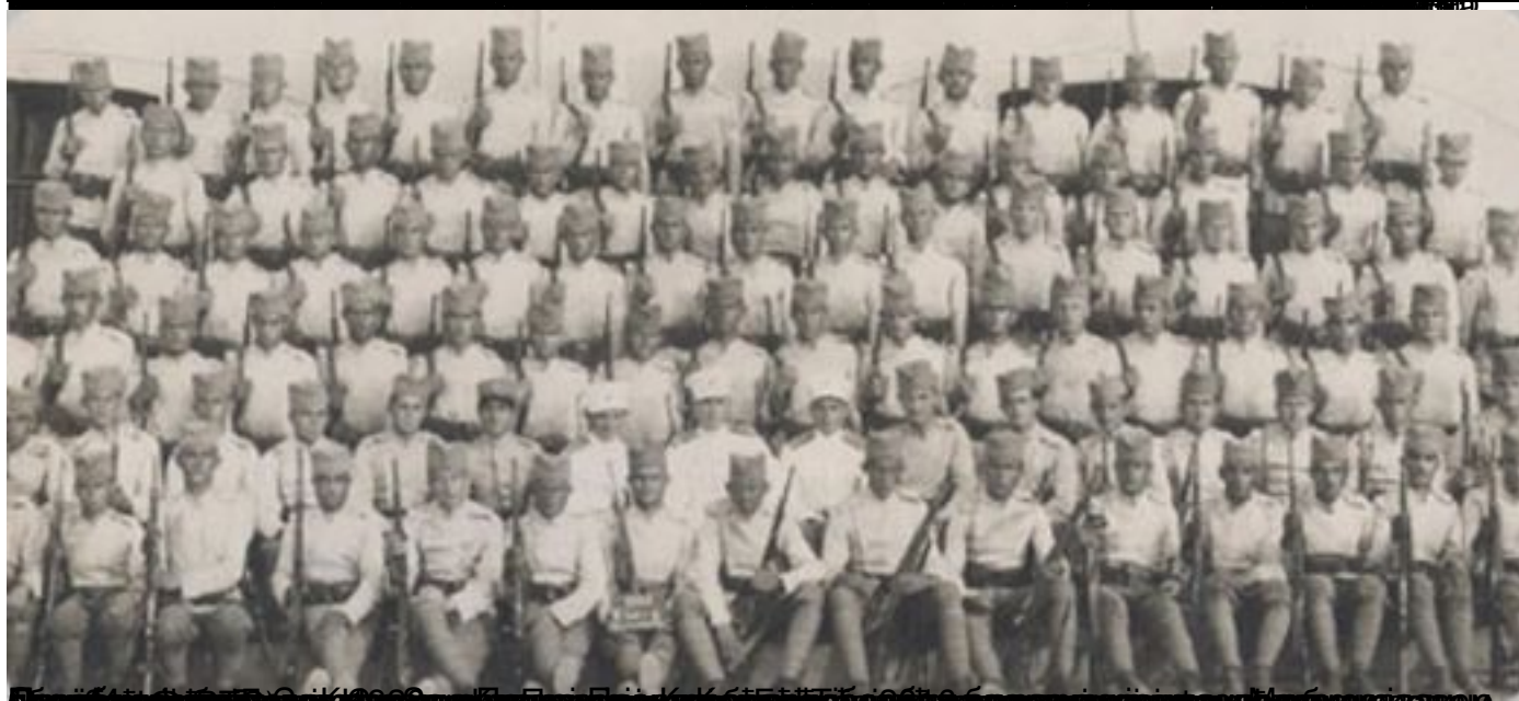
Датум: 12.10.2018. 12:32. Слика: 1/2. Опис: Прокупље: Након седнице Владе, откривен споменик "Гвозденом пуку": Брнабић: Аутопут Ниш-Ме
